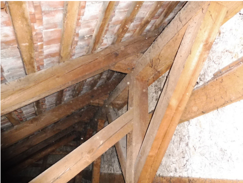
fot. nr 39, 40. Fragmenty więźby dachowej budynku, płatwiowo-kleszczowej wieszarowej dwuwieżakowej, grudzień 2022 r.
