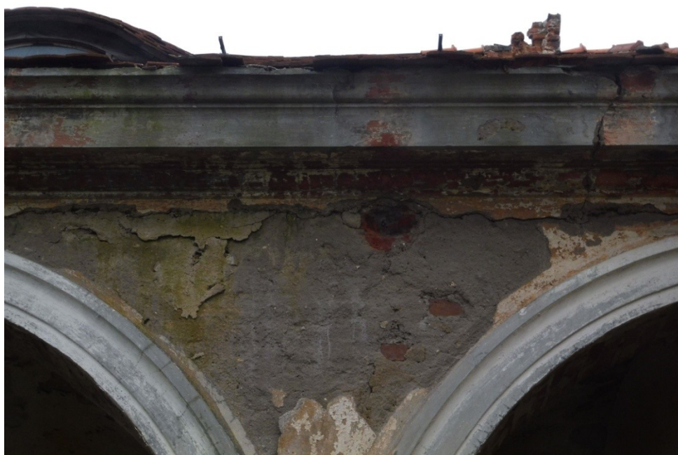
fot. nr 28. Elewacja północna, fragment ściany i gzymsu nad archiwoltami, widoczne liczne odspojenia tynku, spękania ścian, i zaatakowanie powierzchni przez mikroorganizmy, grudzień 2022 r.
