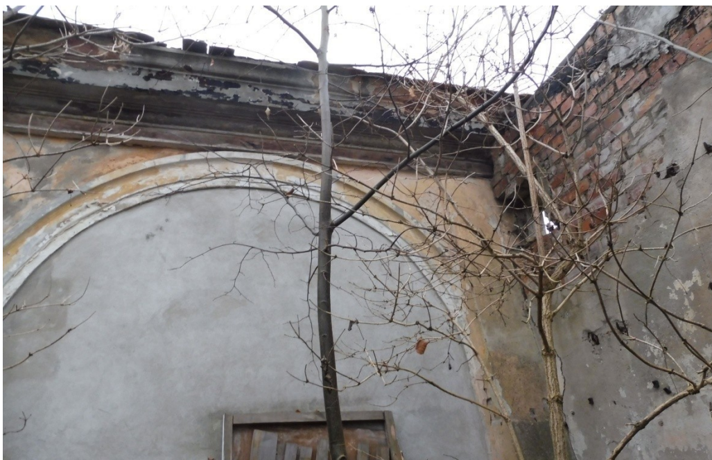
fot. nr 29. Elewacja północna, zamurowane przęsło arkadowe w narożniku północno-zachodnim, grudzień 2022 r.
