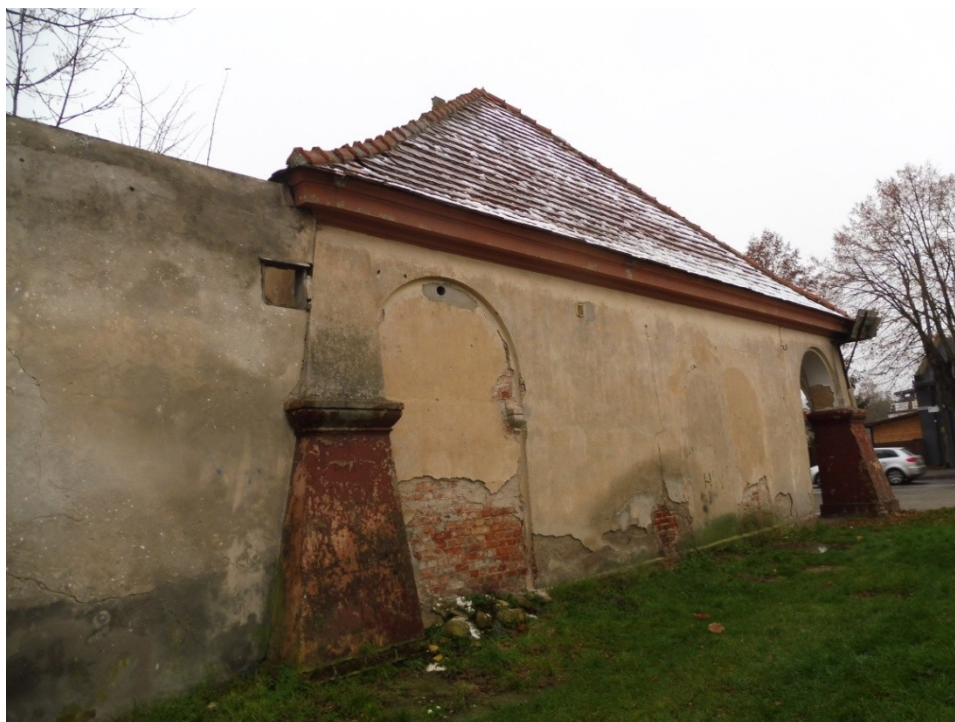
fot. nr 21. Elewacja zachodnia, widoczne brakujące fragmenty tynku, oraz zawilgocenia i mikroorganizmy w strefie przyziemia, grudzień 2022 r.
