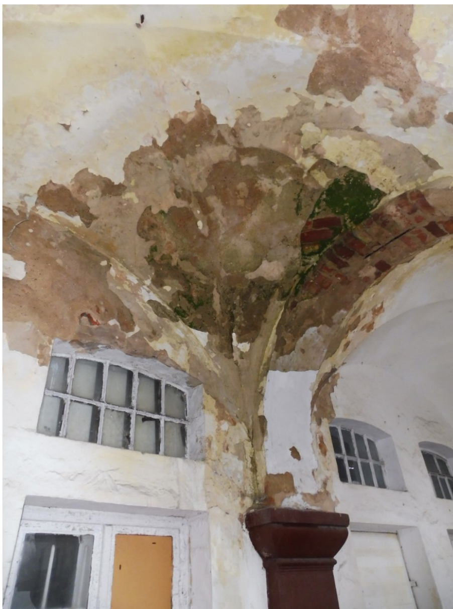
fot. nr 17. Elewacja południowa, sklepienie na jednym z przęseł arkadowego podcienia, widoczne brakujące fragmenty tynku i wypłukane warstwy malarskie. Powierzchnie silnie zawilgocone, porażone mikroorganizmami, grudzień 2022 r.
