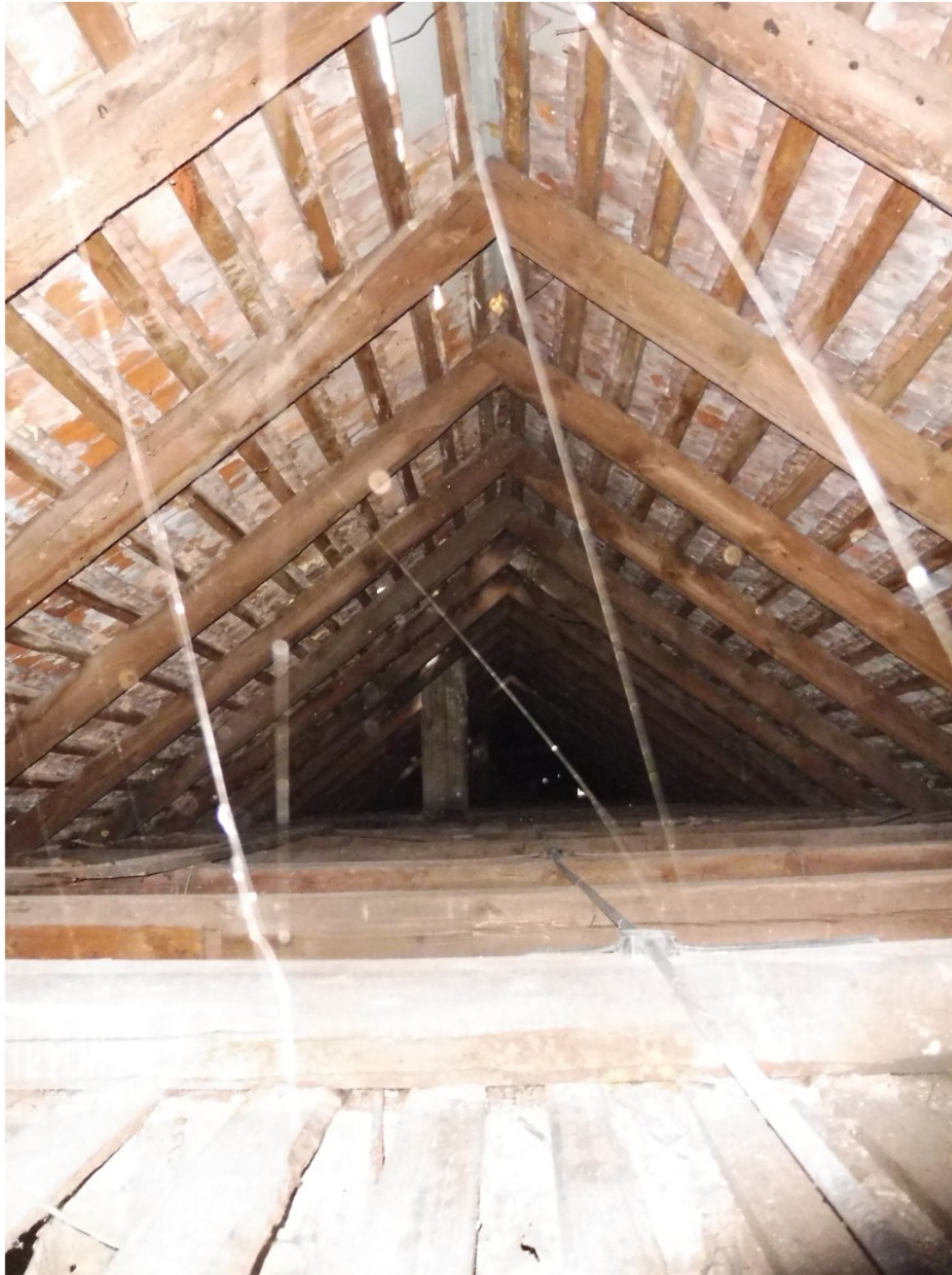
fot. nr 41. Fragment więźby dachowej budynku, płatwiowo-kleszczowej wieszarowej dwuwieżakowej, grudzień 2022 r.
