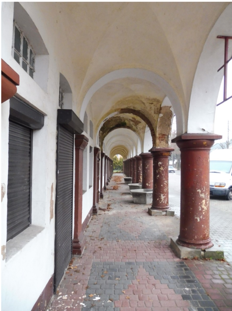
fot. nr 16. Elewacja południowa, arkadowy podcień, widoczne brakujące fragmenty wypraw tynkarskich na płaszczyznach sklepienia, grudzień 2022 r.
