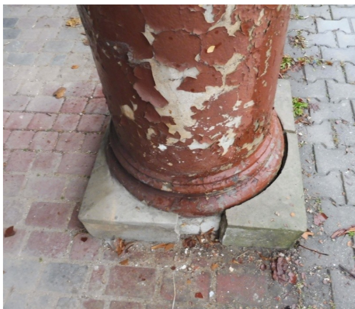
fot. nr 20. Elewacja południowa, fragment jednej z kolumn arkadowego podcienia. Widoczna zdekonstruowana warstwa malarska na trzonie, oraz spękana i odspojona baza, grudzień 2022r.
