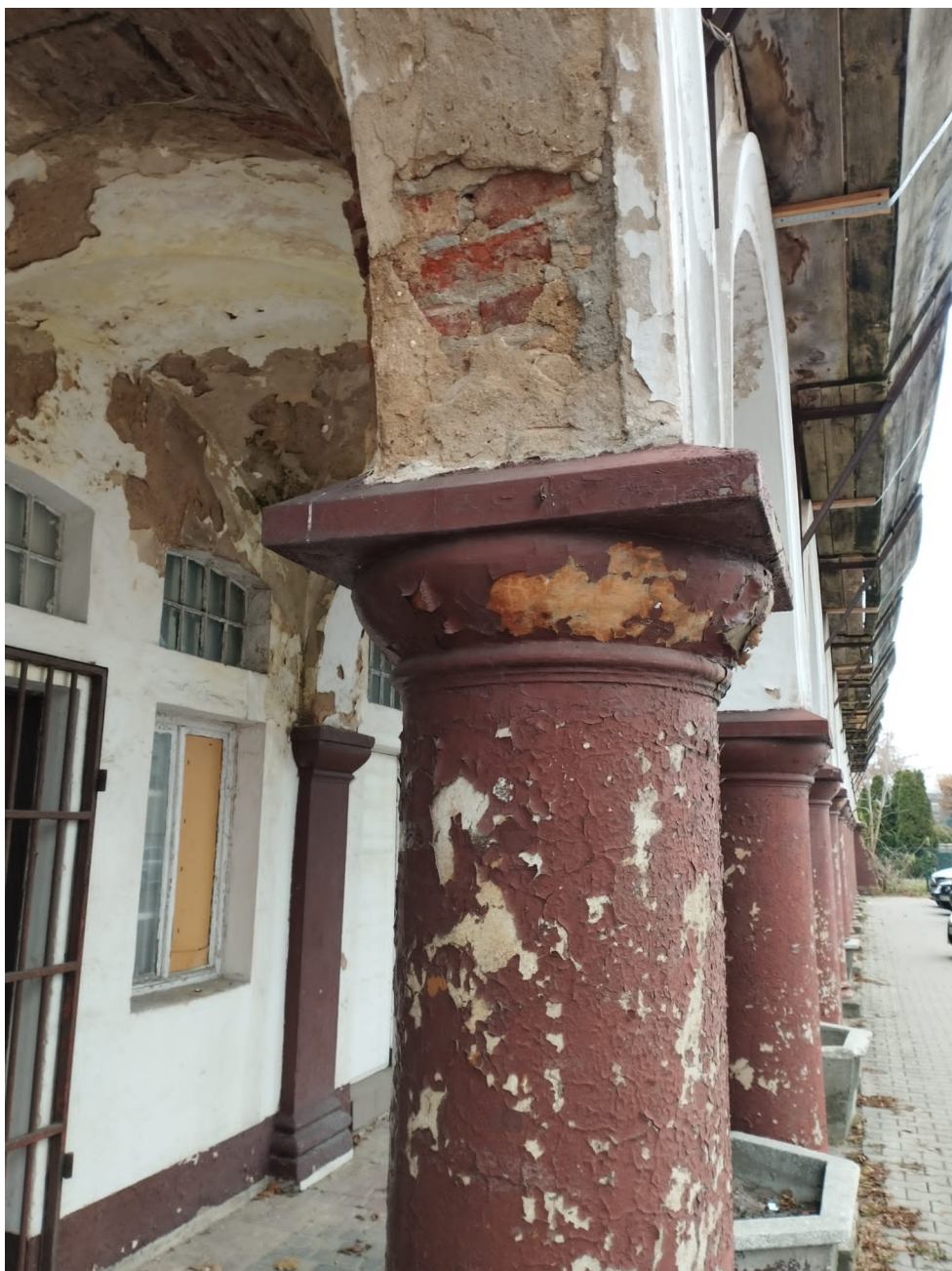
fot. nr 15. Elewacja południowa, fragment podcienia arkadowego, widoczne wypłukane wyprawy tynkarskie i zdekonstruowane warstwy malarskie na elementach architektonicznych, grudzień 2022 r.
