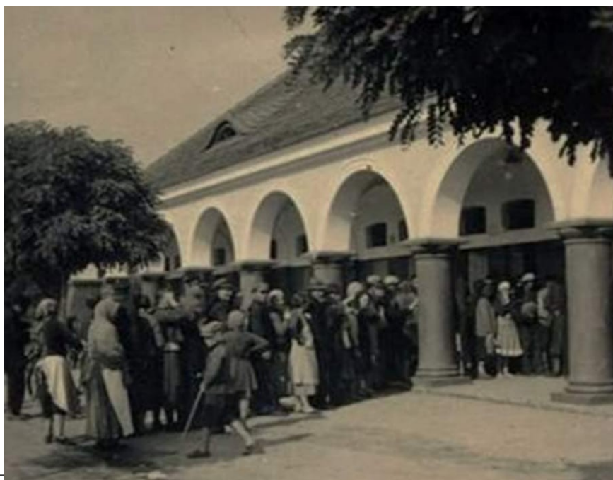
fot. nr 6. Elewacja południowa, fragment podcieni arkadowych z pierwotnym pasem tynku barwionego w masie w kolorze brązowym, biegnącym przez całą długość ściany podcienia, 1939 r. 11
