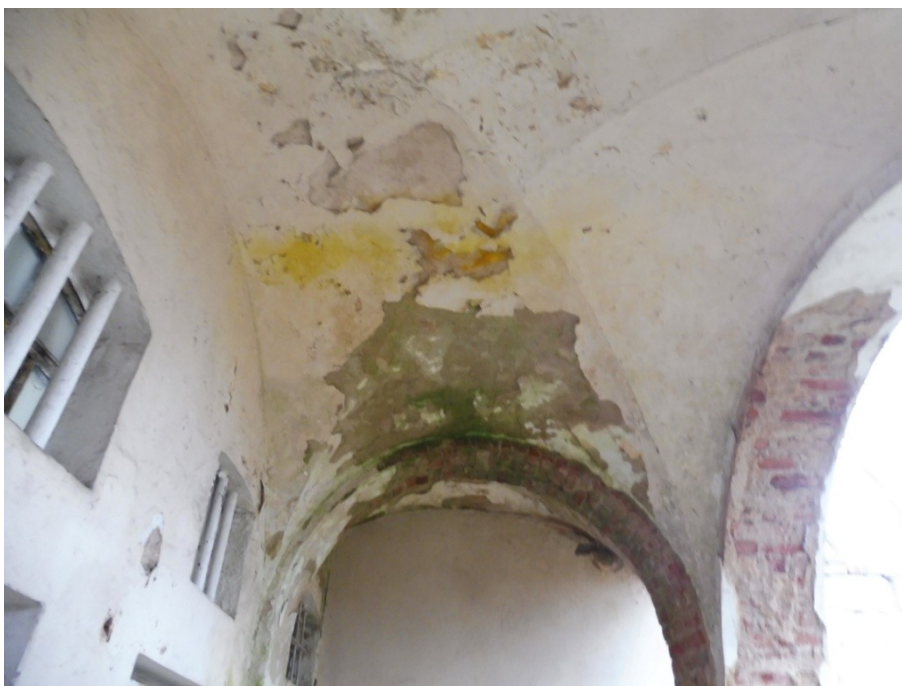
fot. nr 33. Elewacja północna, odspojone fragmenty tynku, wypłukane warstwy malarskie, oraz liczne wykwyty mikroorganizmów widoczne na płaszczyznach sklepienia i gurtów, grudzień 2022 r.
