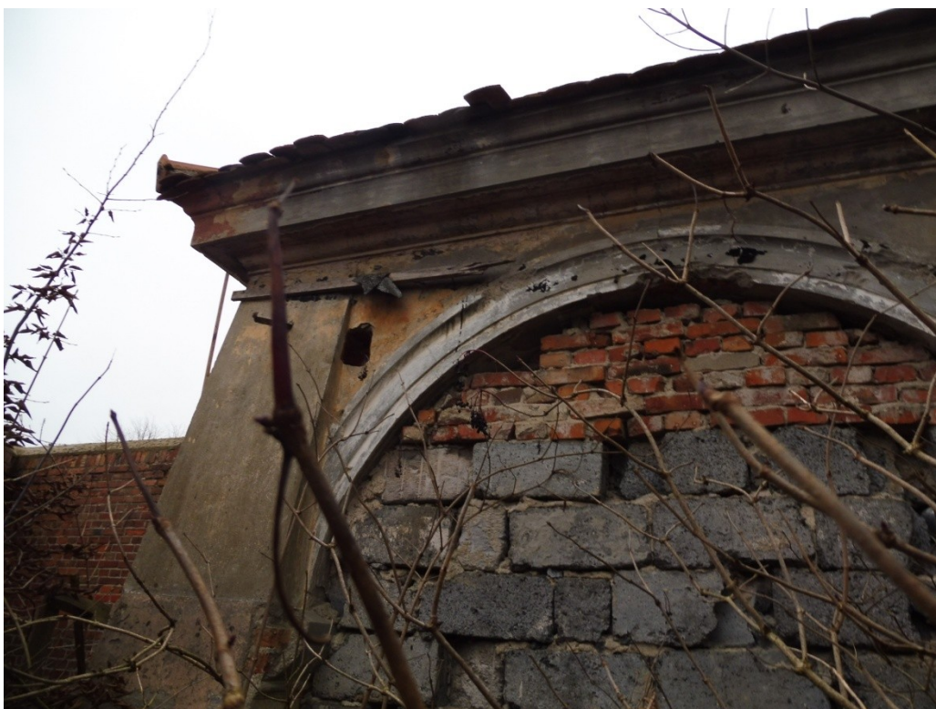
fot. nr 30. Elewacja północna, zamurowane przęsło arkadowe w narożniku północno-wschodnim, grudzień 2022 r.
