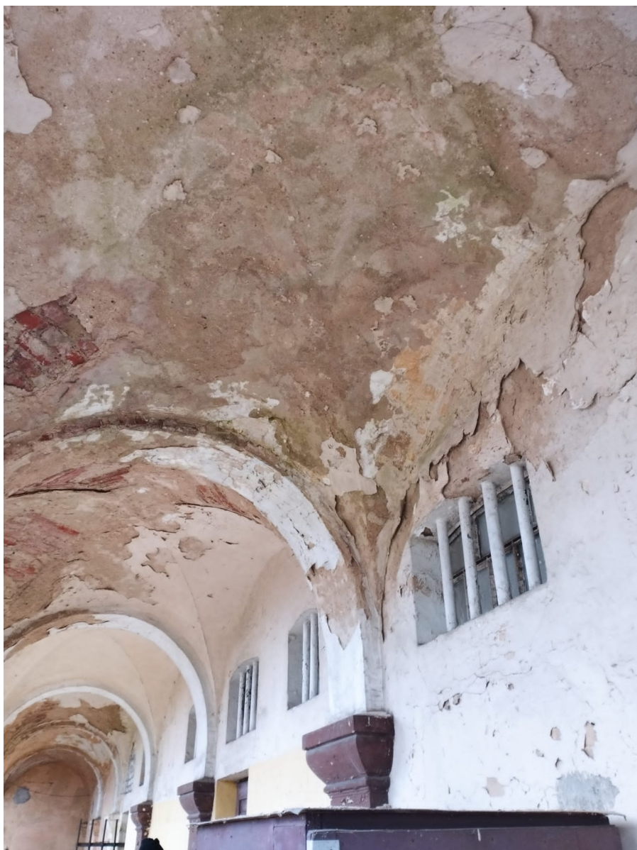
fot. nr 32. Elewacja północna, odspojone fragmenty tynku i wypłukane warstwy malarskie na płaszczyznach sklepienia, grudzień 2022 r.
